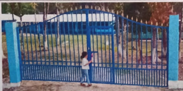
Foto 5: El portón es sustituido en sus totalidad.
